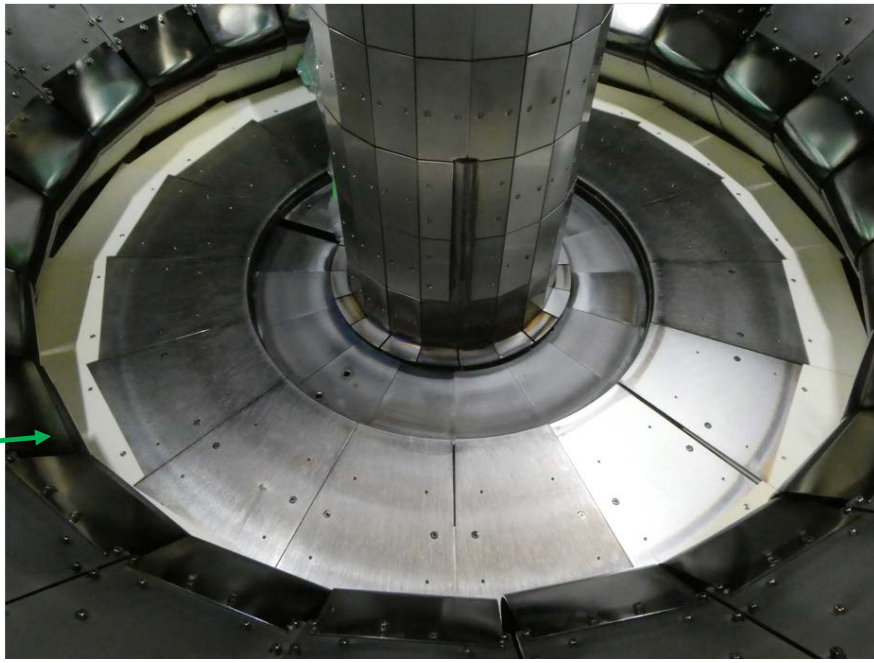
電極カット及びセラミックカバー設置による外側壁間との放電防止処置を実施
